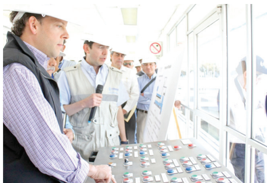
Edificio de control.
