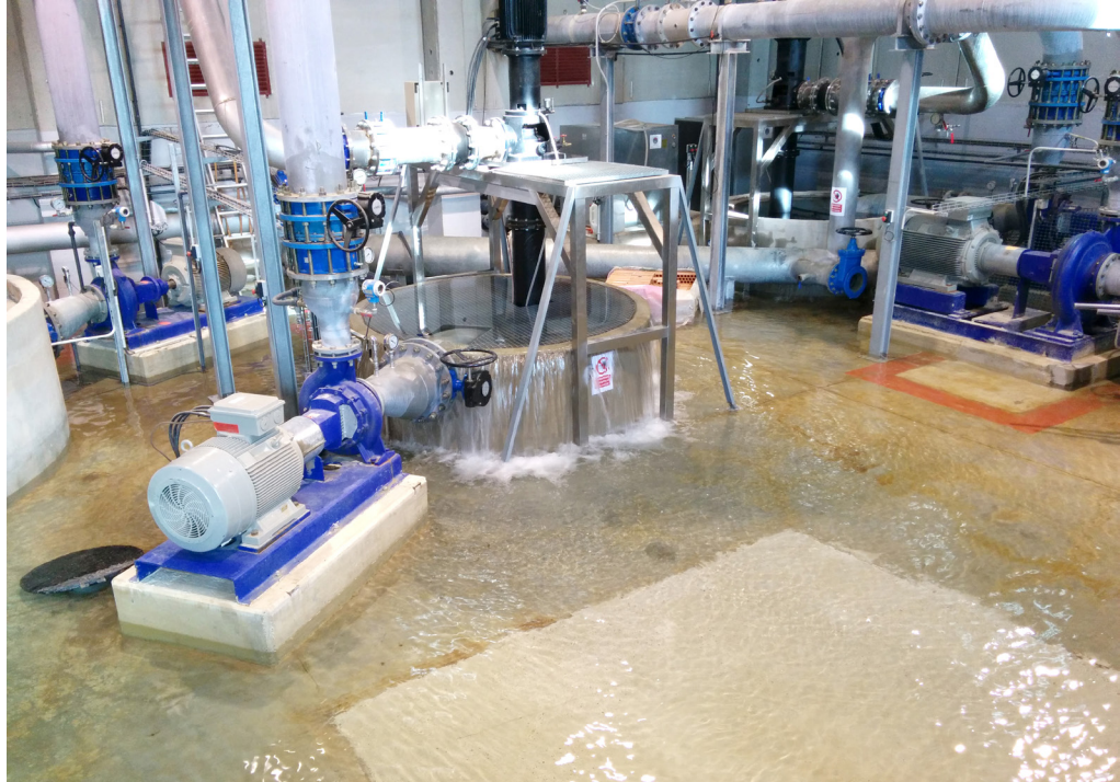
Imagen de la estación de tratamiento de agua potable (ETAP), en el momento en que el agua comenzó a inundar el interior de la planta y cuando se inició el desmontaje y elevación de los equipos.
