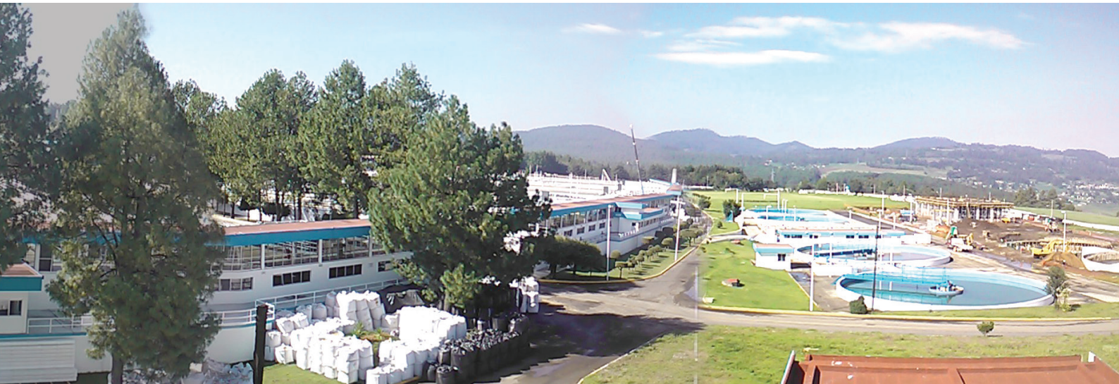
Estación de tratamiento de agua potable de Cutzamala.
