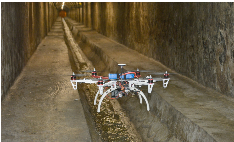
Unos de los drones utilizados para realizar las tareas de inspección de las alcantarillas.
